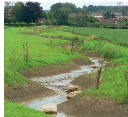
Renaturierung eines Bachlaufs (Einrichtung von Gewässerrandstreifen, Entfernen von Betonhalbschalen, naturnahe Gestaltung des Bachlaufs)
