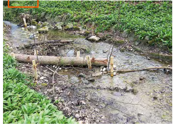
Nach der Umsetzung werden eingebaute Strukturmaßnahmen den Bach auf und bieten Lebensraum für den hier lebenden Steinkrebs.
